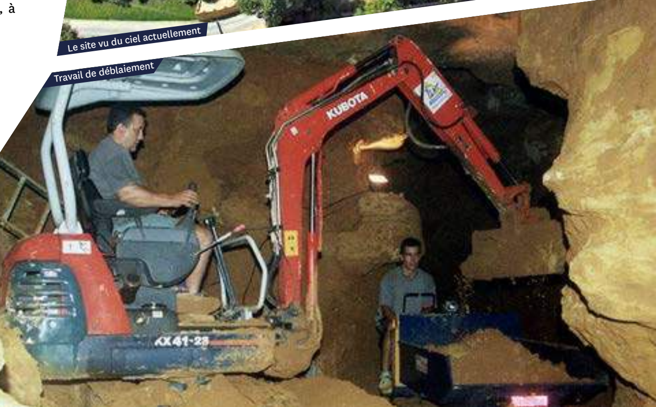
Travaux de terrassement en 2003
